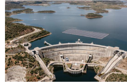
Portugal, Alto Rabagão, 220 kWp, 2017 EDP, Ciel & Terre
