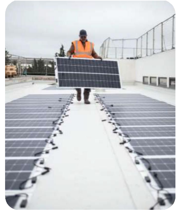
Niort | Bâtiment tertiaire Raccordement début 2025
