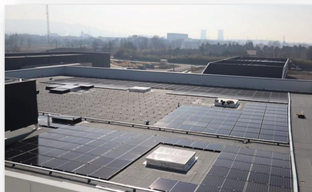
VINCI Energies Pierrelatte – 320 kWc Injection Réseau avec Autoconsommation Collective
