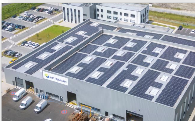
Actemium Dunkerque – 500 kWc Injection réseau avec Autoconsommation Collective
